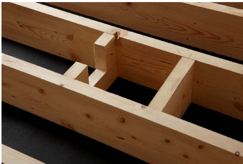
Foto 17. Kortlingar som underlag för montering av golvbrunn.
