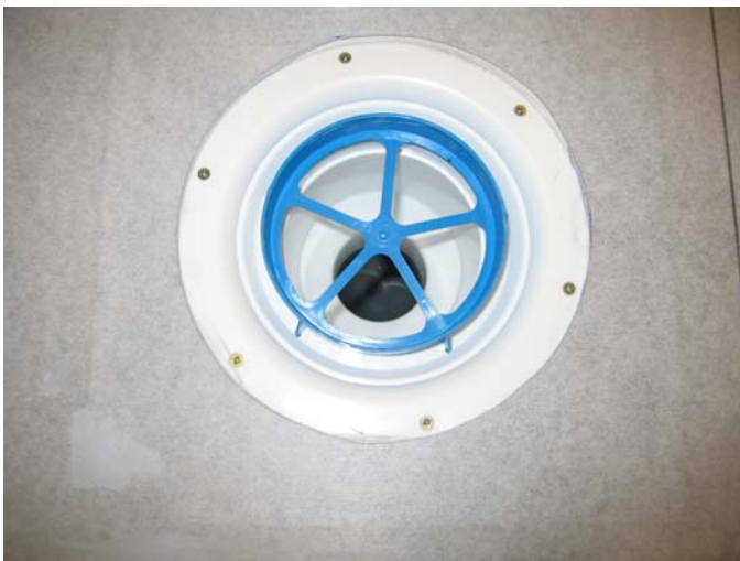
Foto 15. Exempel på uppklippt folie vid anslutning till golvbrunn
