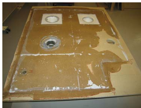
Foto 13. Exempel på en totalskada d.v.s. det finns fritt vatten på nästan alla kontrollpunkter
