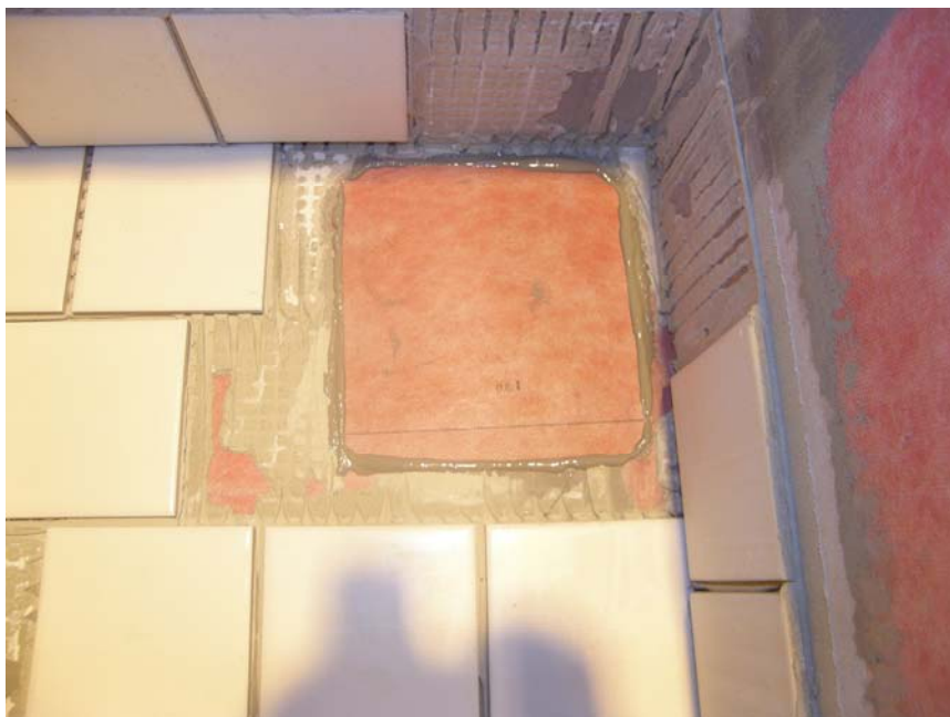
Foto 7. Utförd delreparation på tätskiktsfolie som vid provningen var tät.
