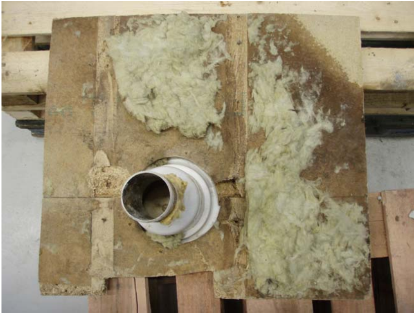
Foto 2. Inga kortlingar samt golvbrunn monterad i skivskarv.
