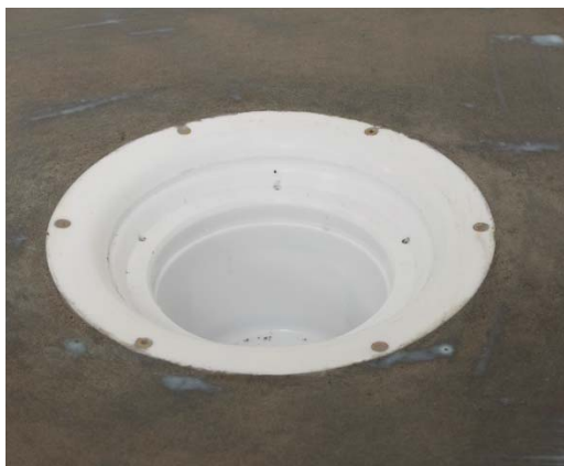
Foto 20. Flytspackel i nivå med golvbrunnens fläns som är rengjord och avfettad.
