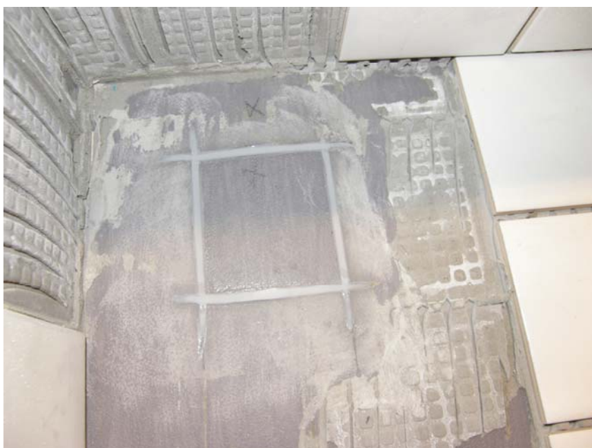
Foto 8. Utförd delreparation på plastmatta som vid provningen var tät.
