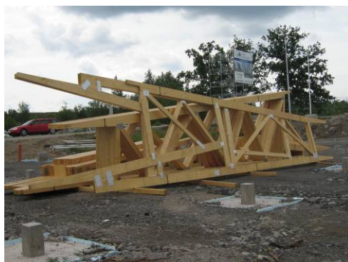
Bild B.6.6 Takstolar på mellanlagring.
