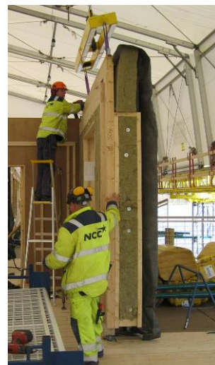
Bild A 14 Montage av ytterväggselement.
