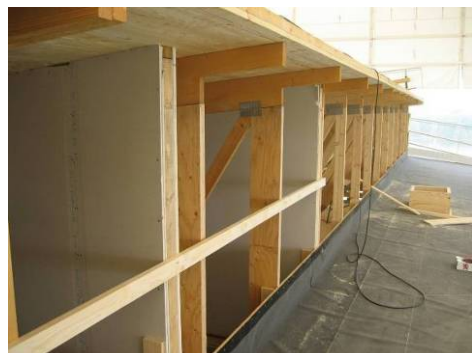
Bild A 30 Tacknock och brandväggar på vind.
