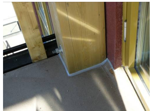
Bild B.4.3 Balkongpelare på den nordvästra fasaden.
