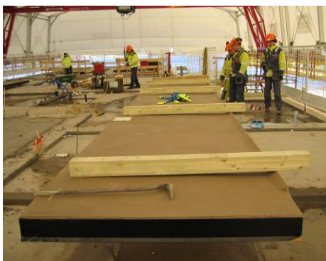
Bild B.5.6 Balkongelement i väntan på montage.
