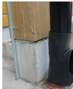
Bild B.4.2 Balkongpelare på betongsoclel
