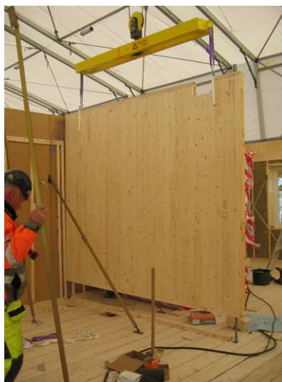
Bild A 19 Montage av stabiliserande massivträvägg.
