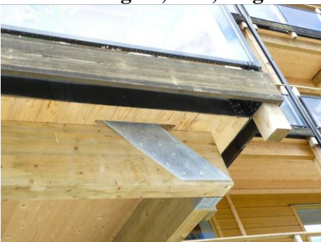
Bild B.4.1 Balkonger sedda underifrån.
