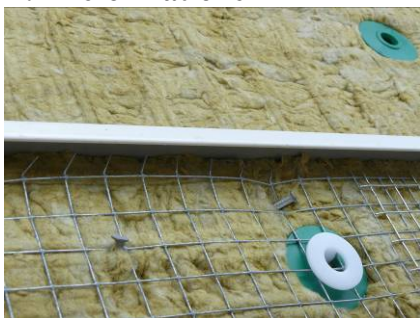
Bild B.7.1 Horisontell dilatationsfog i fasad innan all nätarmering monterats.
