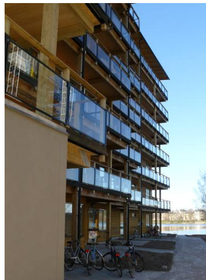
Bild A 10 Del av fasad mot sydost
