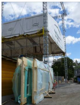
Bild B.6.2 Inplastade väggelement.
