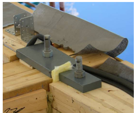
Bild B.1.6 Förankring av dragstag ovanpå väggelement i plan 8.
