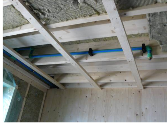
Bild B.2.3 Sprinklerledningar i undertak bjälklagselement. Komplettering med isolering och glespanel återstår
