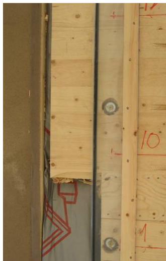
Bild A 12 Tätning med s-list på bjälklag under vägg. Monterad styrlist till höger. Balkongplatta till vänster.
