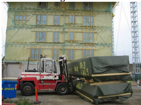
Bild B.6.1 Bjälklageelement som flyttas med truck till lyftzon.
