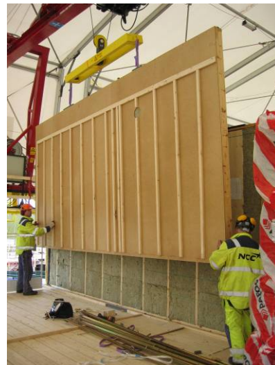
Bild A 17 Montage av andra halvan av lägenhetsskiljande vägg
