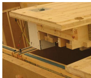
Bild A 23 Montage av bjälklagselement sett från änden i den bärande riktningen för bjälklaget.
