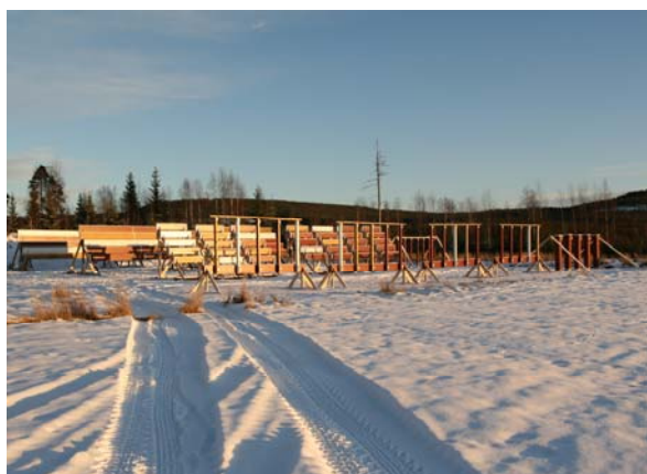
Färdig provgård med balkar och stolpar.
