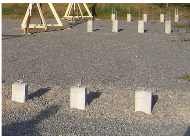
Fundament för stolpar.
