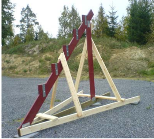
Ställning för uppläggning av balkar.
