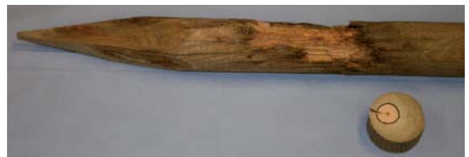
Stängselstolpe med full inträngning av träskyddsmedel (se tvärsnittet) som på kort tid fått omfattande rötskada i markbandet. Foto: Anders Clang.
