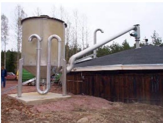
Bild 6. Kylare och kompostfilter med vattenlås.
