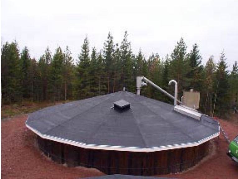
Bild 5. En av två lagrings- och behandlingsbehållare vid våtkomposteringsanläggningen.
