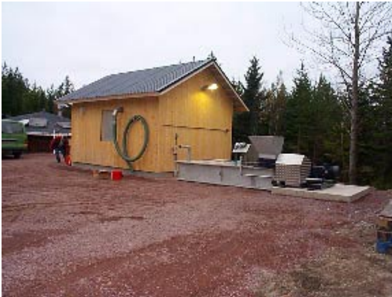
Bild 4. Mottagningsdelen, samt huset där pumpen som transporterar materialet till lagrings- och behandlingsbehållarna står.
