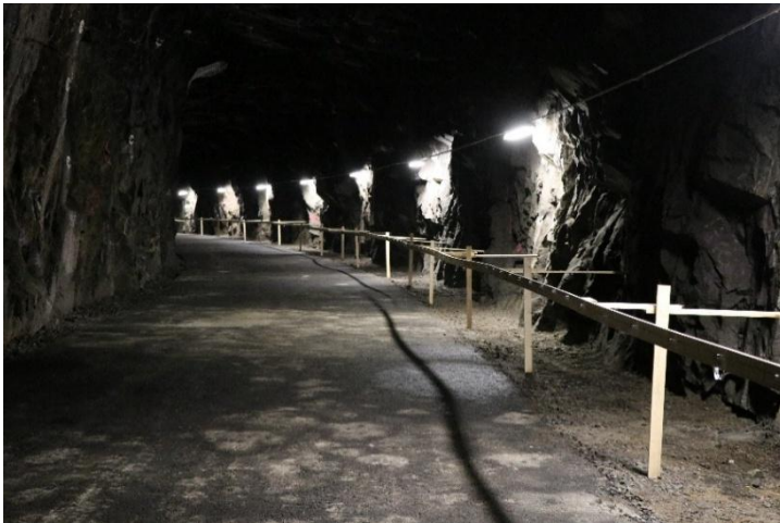
Figur 2. Försökstunneln. Bild tagen i mitten av tunneln i riktning mot den norra tunnelmynningen. Till höger är provisorisk handledare monterad.
