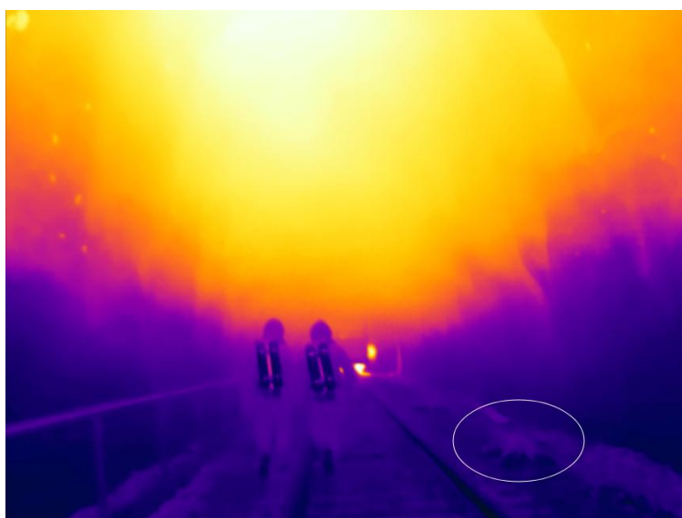
Figur 10. Räddningsdockans placering (markerat med vit linje) i den tomma delen av tunneln.
