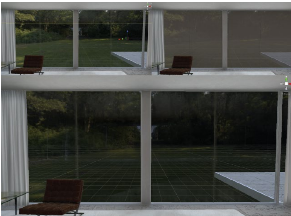
Figur 3: Bilder från demonstratorn. Översta raden från vänster är helt utan solskydd överst till höger är med fysiskt skydd (fasadmarkis). Stora bilden är med ChromoGenics smarta fönster.
