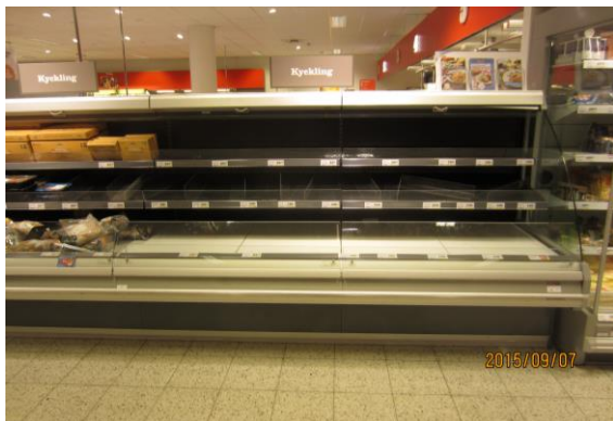
Figur 4 Demonstrationen gjordes i ändsektionen av en treplans kyldisk bestående av flera sektioner som kyls med var sitt kylbatteri.
