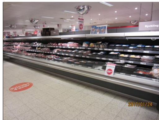
Figur 4 Demonstrationen gjordes i ändsektionen av en treplans kyldisk bestående av flera sektioner som kyls med var sitt kylbatteri.
