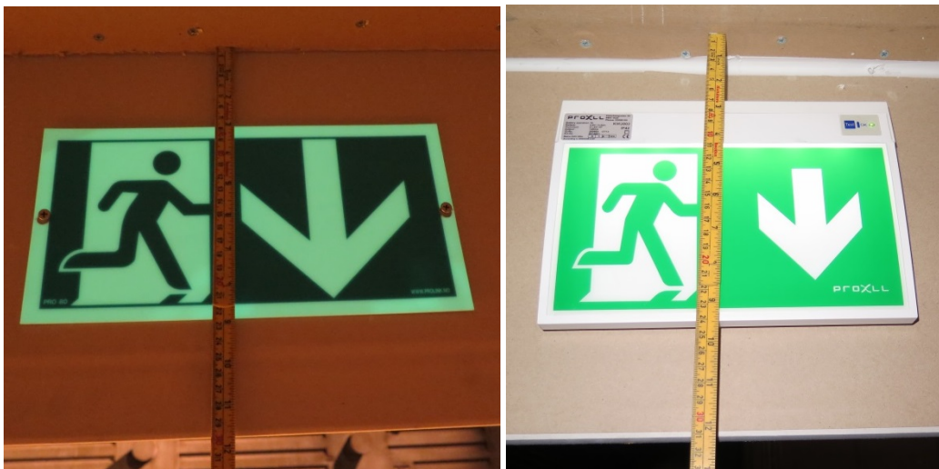
Figur A- 5: Forsøk 1. Detaljbilde av montering av markeringsskiltene. Begge er montert sentrert mellom tak og korridoråpning.
