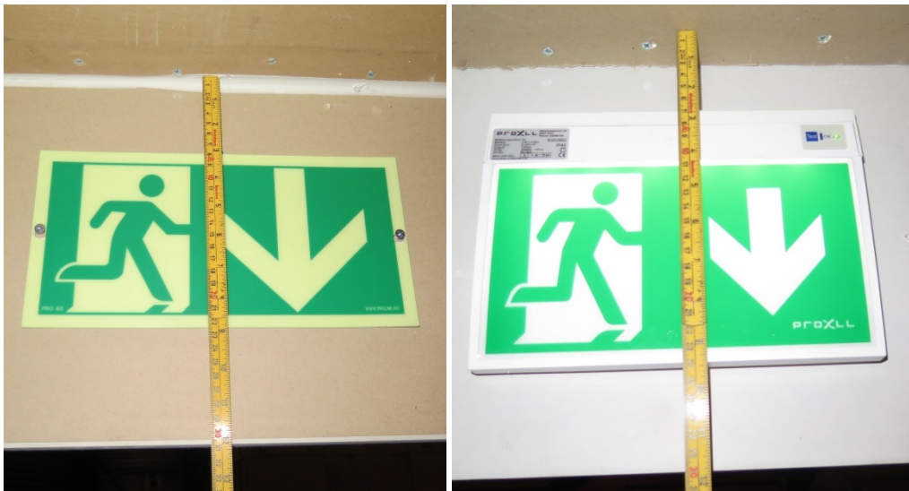
Figur A- 7: Forsøk 2. Detaljbilde av montering av markeringsskiltene. Begge er montert sentrert mellom tak og korridoråpning.
