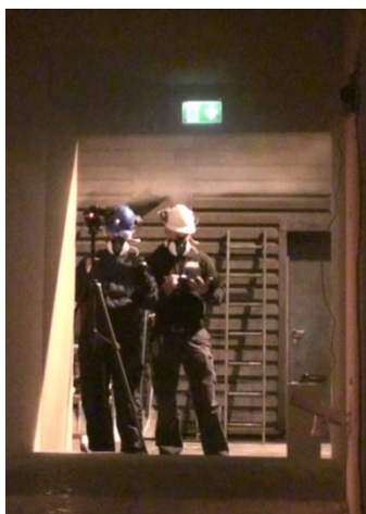
2:50 Første sprinkler korridor løser ut
