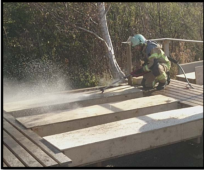
Figur 13: Övningsmoduler för att öva konstruktionsbrand på Storgöteborgs brandövningsplats Karholmen. Foto Lotta Vylund.
