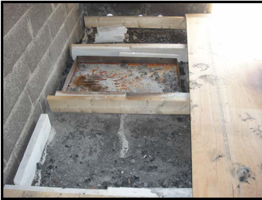
Figur 14: Övningsmodul för att identifiera och släcka konstruktionsbränder. Foto Krister Palmkvist.
