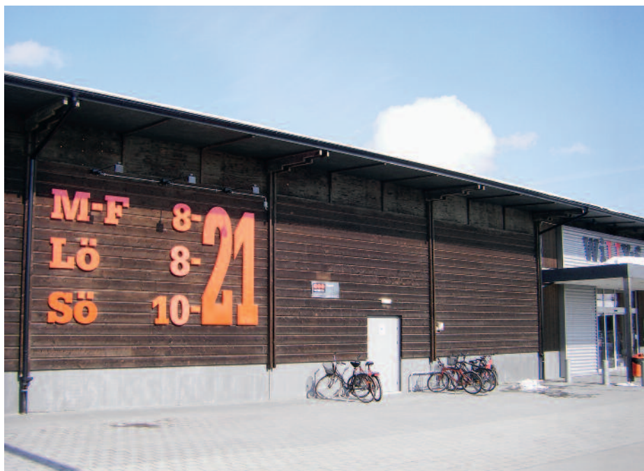
Handelscentrum med järnvitriolbehandlad limträpanel, Skellefteå.
