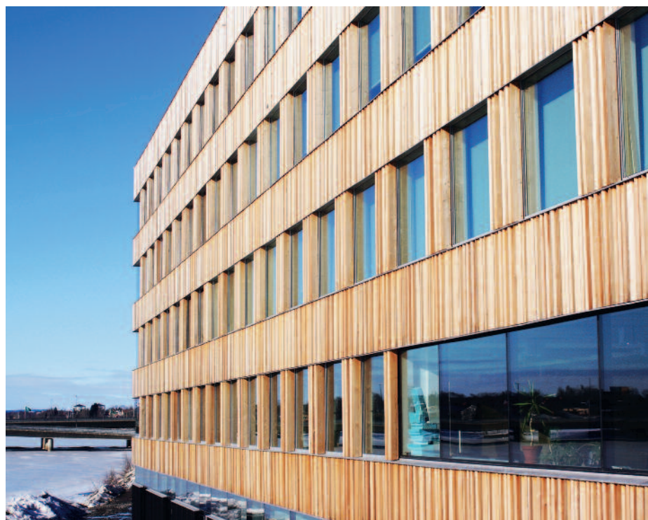
ArkitektHögskolan i Umeå med fasad av obehandlad lärk.
