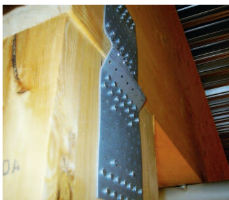
Figur 33: Tryckbrott vinkelrätt fibrerna vid balk-pelarslutning.
