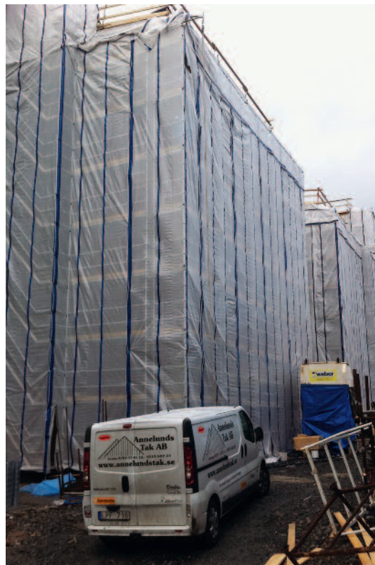
Moelven Töreboda bygger sexvåningshus i Askim.
