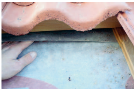
Bild 6: Otät skarv i underlagstaket. Risk för att vatten och yrsnö kan tränga in och inläckaget kan bli omfattande om en betongpanna går sönder.
