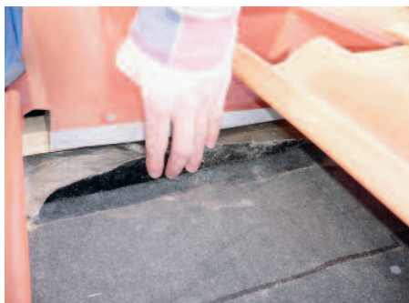
Bild 5: Tätningsremsa ska täta mellan takpapp och genomföring.
