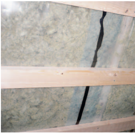
Bild 8. Oklämd plastfolieskarv med tejpad skarv.
