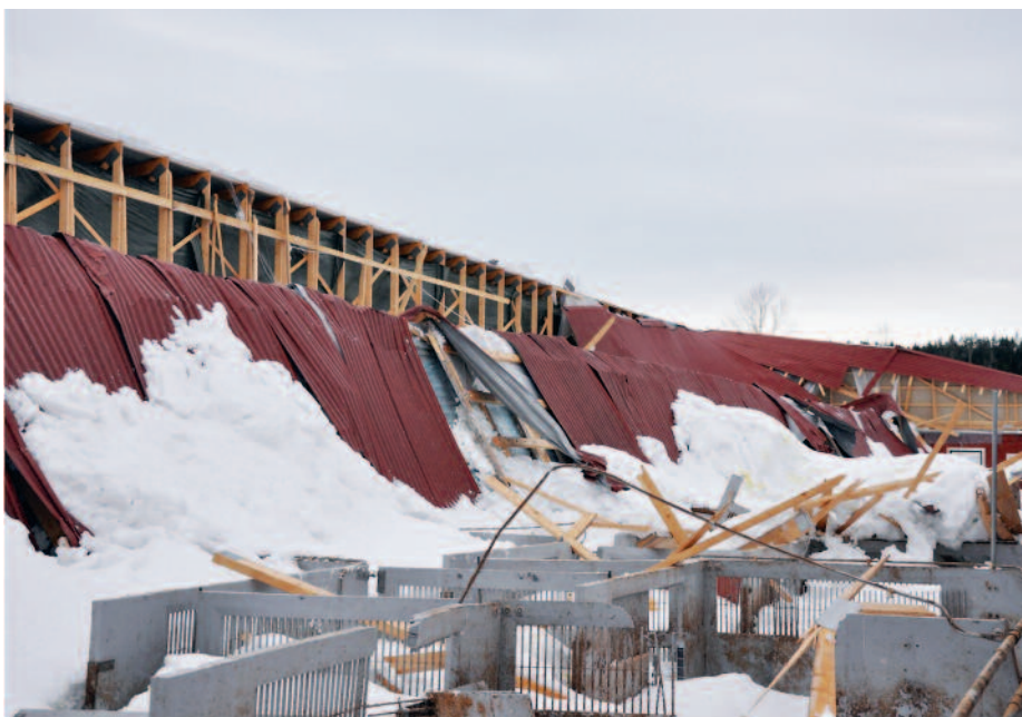
Bild 12: Takras orsakat av både projekteringsfel och eventuellt utförandefel, Johansson et al (2011).
