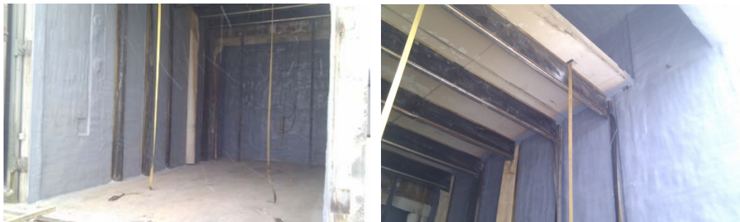
Figur 2: Kammartork efter beläggning av isolering och tätskikt.
