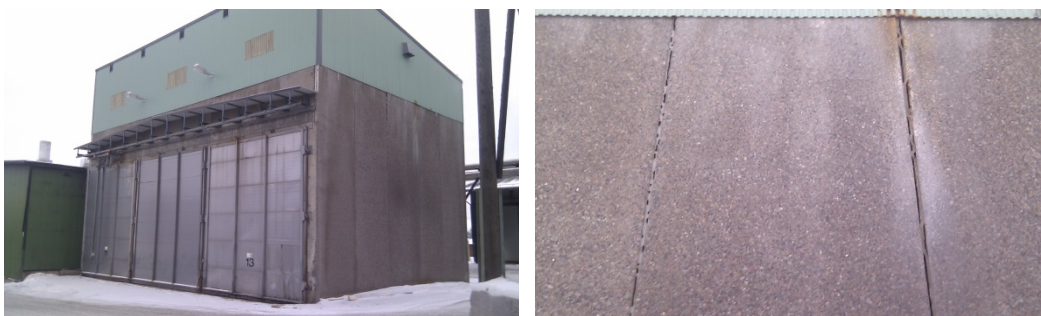
Figur 1: Kammartork 11 till 13 och fogar i kammare 13 före renovering.
