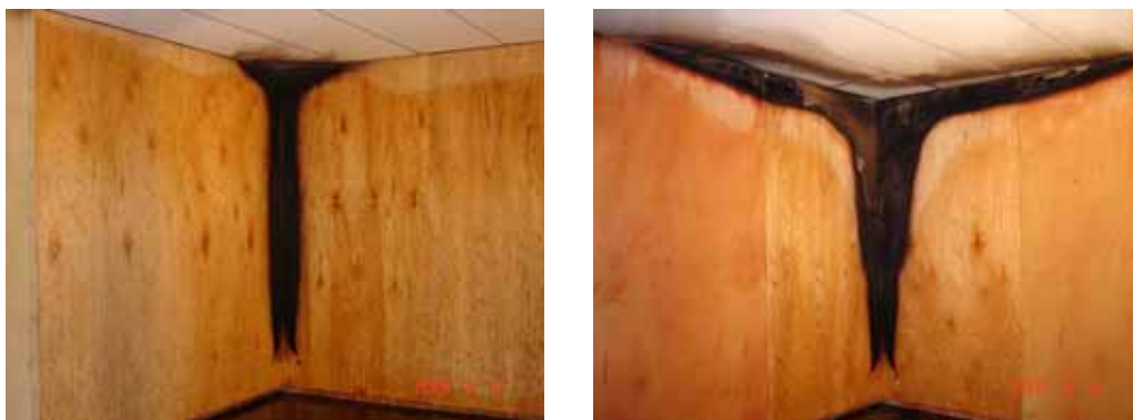
Figur 2 Illustrativa resultat från två sprinklerförsök som visar att den relativa brandskadan blir större, se den högra bilden, när mindre mängd vatten från en sprinkler träffar väggytorna. Brandkällan bestod av en 100 kW gasolbrännare som placerades mot hörnets väggar (visas ej på fotona).
