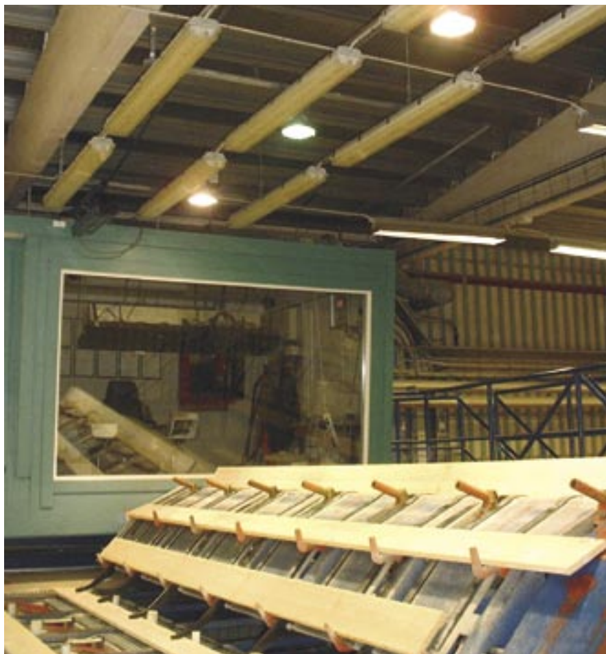
I justerverket ersattes nio lysrörsarmaturer med två rör à 58 W (1044 W) med tre CDM-lampor à 150 W (450 W) samtidigt som ljusstyrkan ökade.
