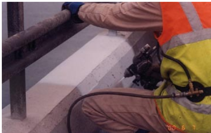
Figur 1. Termisk sprutning av kantbalk med flamsprutningsteknik, Ölandsbron.
