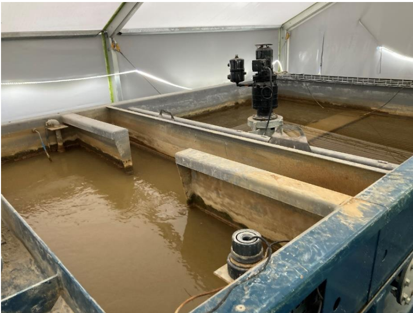
Figur 16: Container med kemisk fällning, flockning och flotation.
