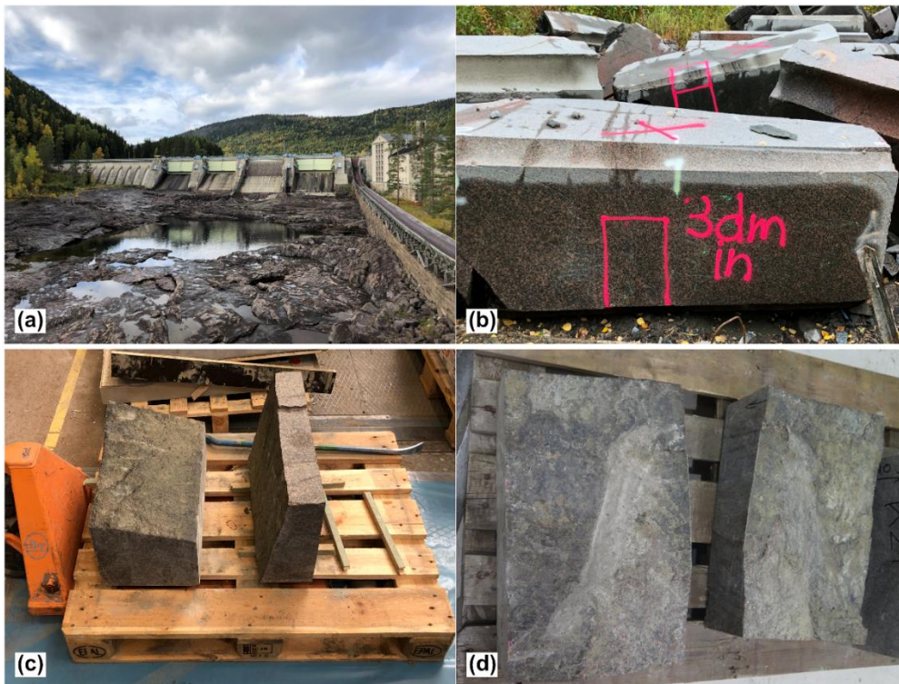
Figur 2. a Damm vid Krångede; b stora bergblock som lyftes upp från de vertikala schakten i anslutning till det befintliga kraftverket; c bergprov K1 innan skjuvförsök i laboratorium; d bergprov K2 innan skjuvförsök i laboratorium (efter Ríos-Bayona et al. 2022 [2], CC BY 4.0, https://creativecommons.org/licenses/by/4.0/ ).
