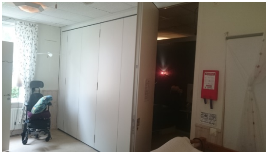
Figur 2. Vikvägg DV65 från SWG, installerad av Diedrichs AB på ett särskilt boende.
