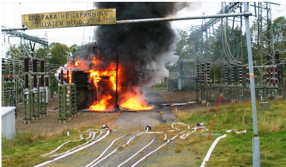
Foto nr 1. Slangarna är framdragna men strömmen är fortfarande påslagen...
