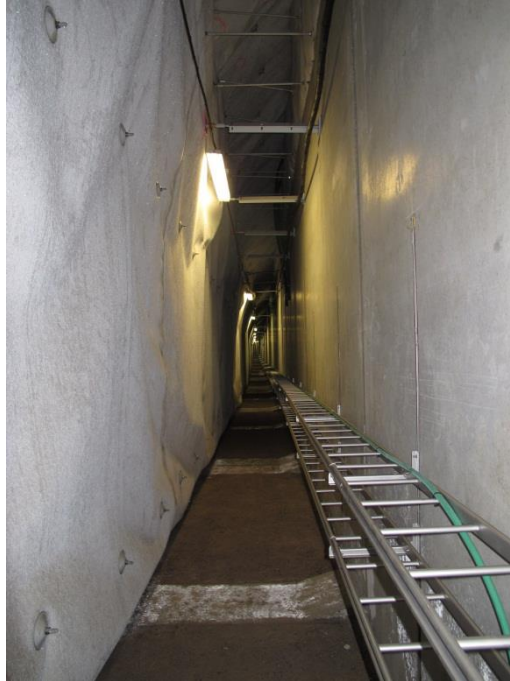
Figur 2: Bild som visar teknikutrymmet (installationskorridor), betongelement (höger sida) och duken som ligger mot berget (vänster sida) (Foto: RISE).
