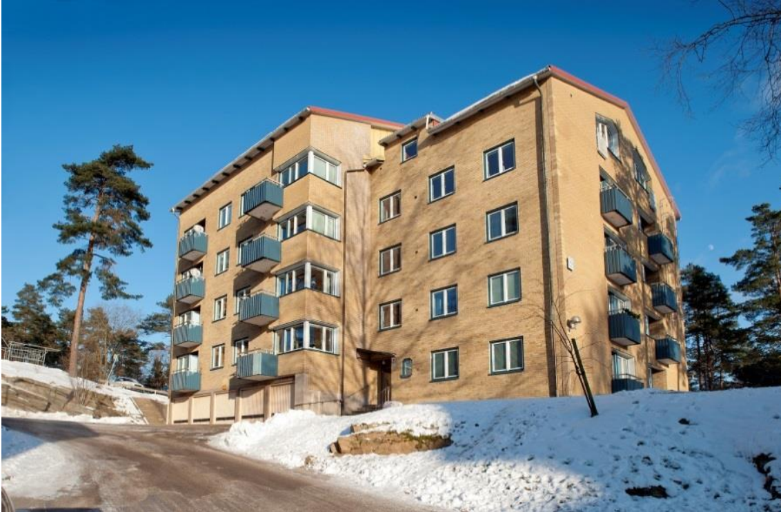
Figur 2. Ett av de studerade husen på Vintergatan i Borås. Bild: AB Bostäder i Borås.
