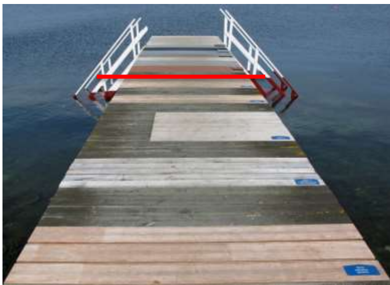
Figur 5. Brygga J, 2014-06-10, kompletterad med flera trämaterial som installerades 2014-03-14 (under det röda strecket).
