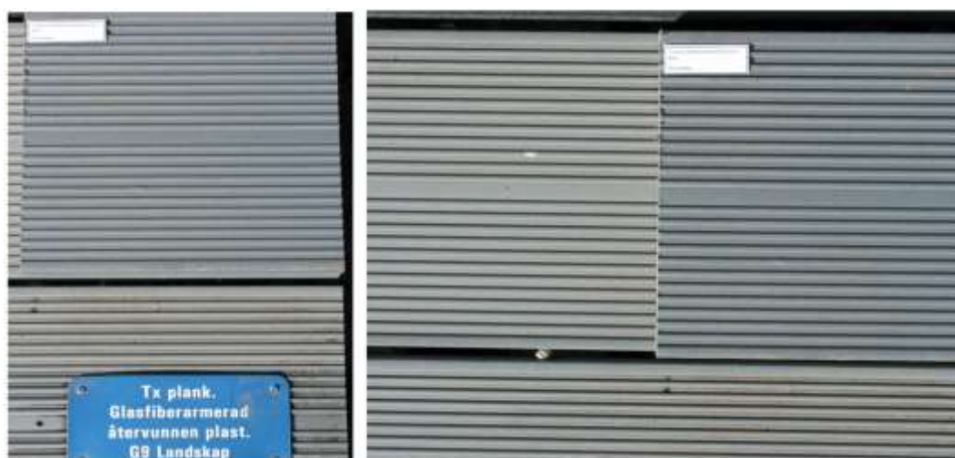
Figur 26. TX plank G9 Landskap, komposit av återvunnen plast.
