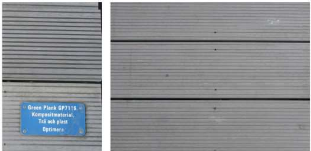
Figur 28. Green Plank GP7116 grå, trä-plastkomposit.
