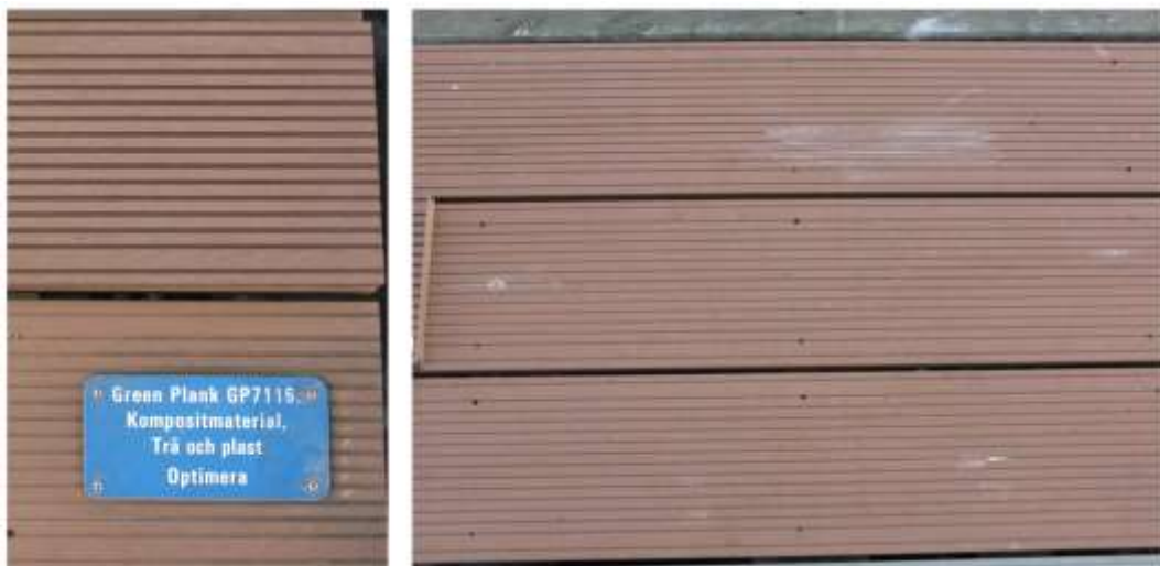
Figur 29. Green Plank GP7116 röd, trä-plastkomposit.
