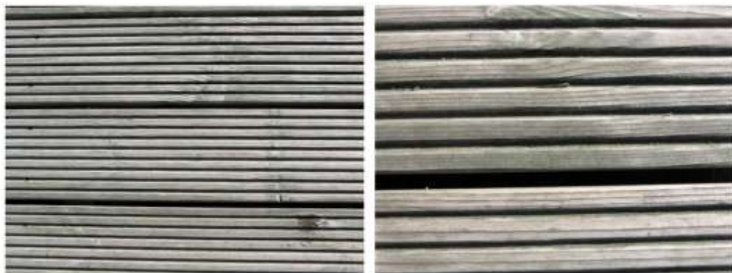
Figur 10. Närbilder av rillad furukärnved med ytbehandling med Sioo.
