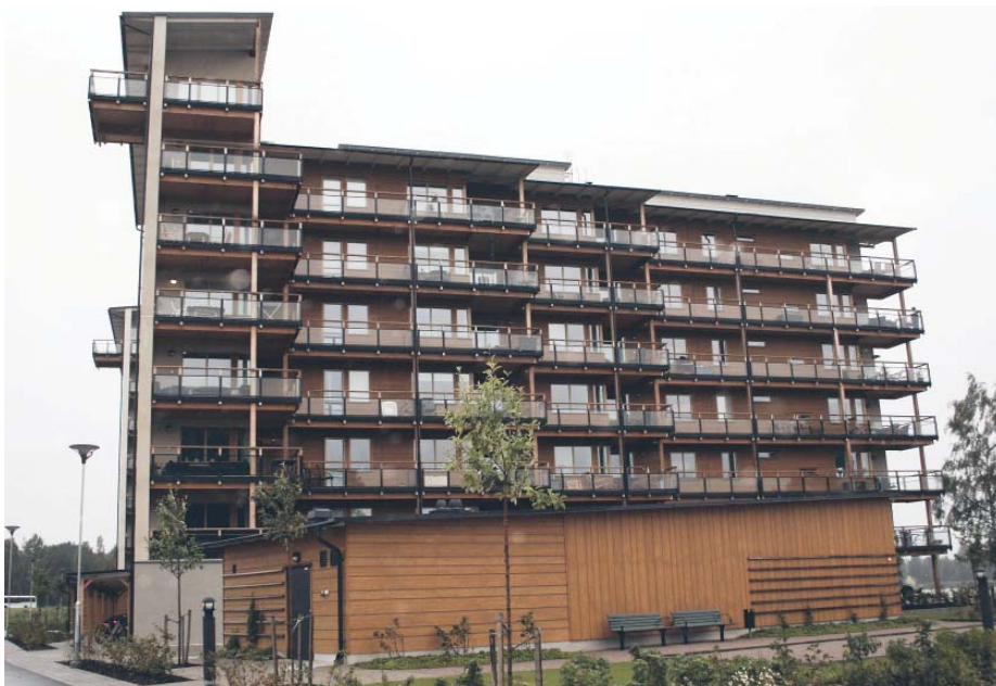
Linnologen i Växjö, som är uppfört i lätt byggt teknik, vann nyligen stora samhällsbyggnadspriset. Akustik och vibrationer har utvärderats inom AkuLite.
