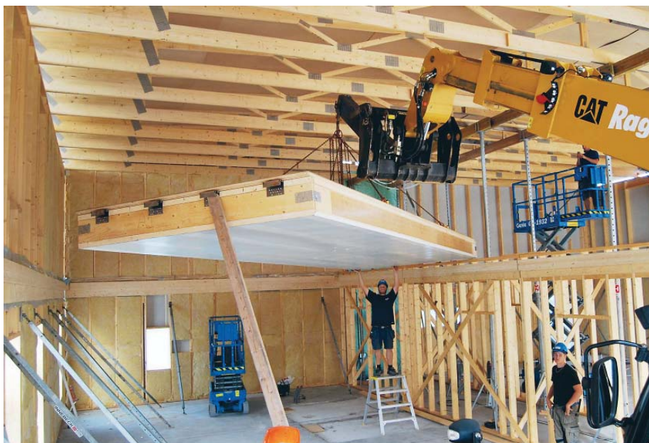
Montage av lättelemt i det nya elevhemmet i Lindesberg.
