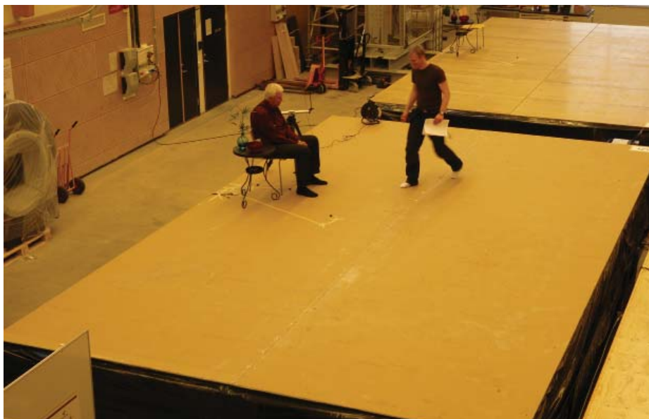
Moderna bjälklag har utvärderats i Växjö genom både subjektiv upplevelse och objektiva mätningar.
